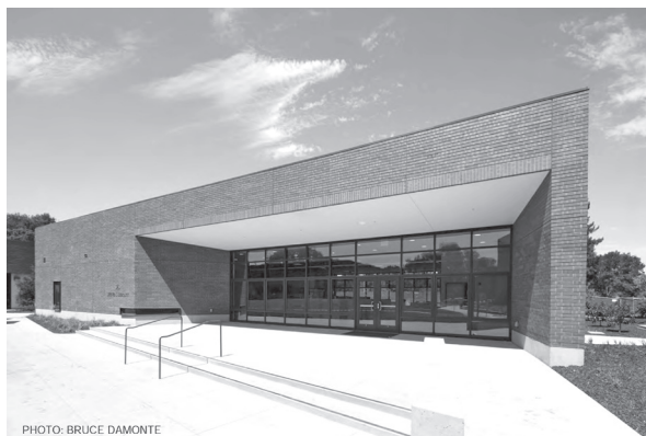
شکل شماره ۱۹- نمای جنوب غربی کتابخانه استیونز
