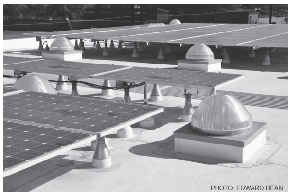
شکل شماره ۲۲- پانل‌های فتوولتائیک نصب‌شده بر روی بام کتابخانه «استیونز»
