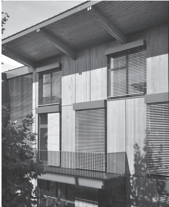
شکل شماره ۱۰- سایه‌بان‌های ساختمان پاکارد
