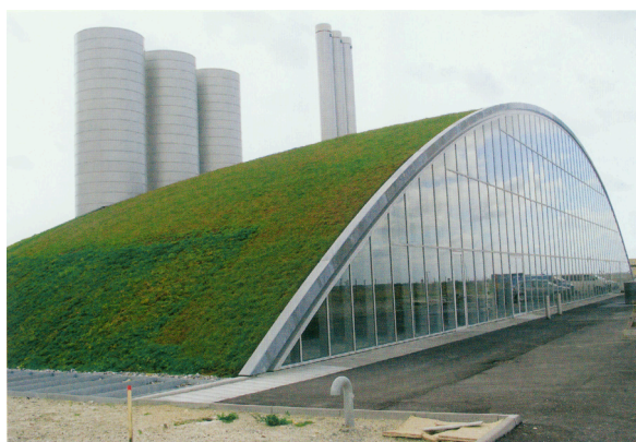
تصاویر ۱۴ و ۱۵: مراحل پیشرفت کار نصب بام سبز سدومی در فرودگاه «کپنهاگ» در دانمارک
