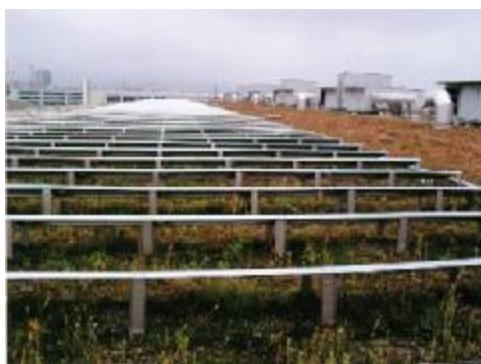
تصویر ۱۸: نمایی دیگر از تاسیسات فتوولتاییک واقع در «اکزیبیت هال» شهر «بازل» در سوییس. در این تصویر مشخص است که پنلهای فتوولتاییک بزرگ در سطح گسترهای در بام‌های پوشیده از سوم مورد استفاده قرار می‌گیرند.
