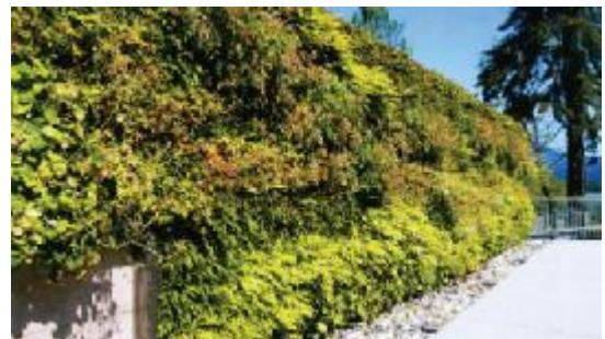
تصویر<sup>۴</sup>: دیوار زنده مرکز آموزشی آکوافست<sup>۳</sup> در آکوایپوم ونکوور. این دیوار زنده از ۲۵۰ واحد پنل دیواری زنده (ساخته شده توسط شرکت جی اسکای<sup>۴</sup>) ساخته شده است.
