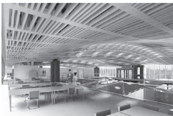
شکل ۴۷- سقف چوبی ساختمان آرک- تک- لب ساخته‌شده توسط ربات
