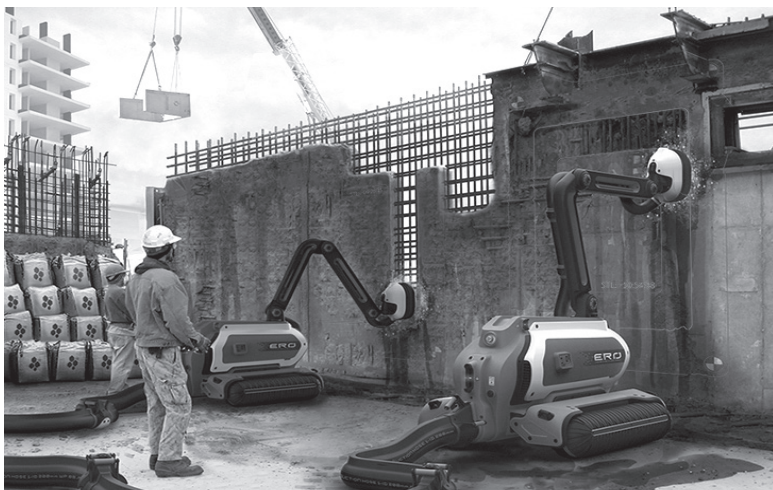
شکل ۵۱- رباتی که با جداسازی بتن از مواد زاید، بتن را بازیافت می‌کند.
