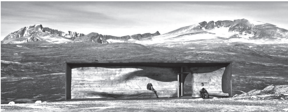
شکل ۲۸- شکل منحنی چوبی ایجادشده توسط فِرَز چوب ۴ و ۵ محوری
