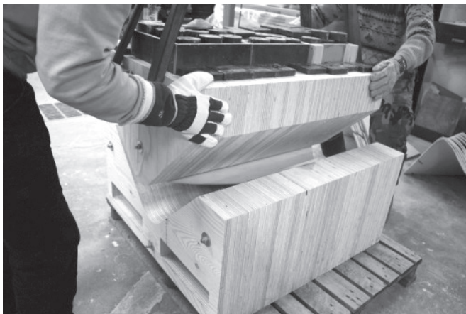
شکل ۳۳- نحوه فرم‌دهی به پوشش چوبی غرفه
