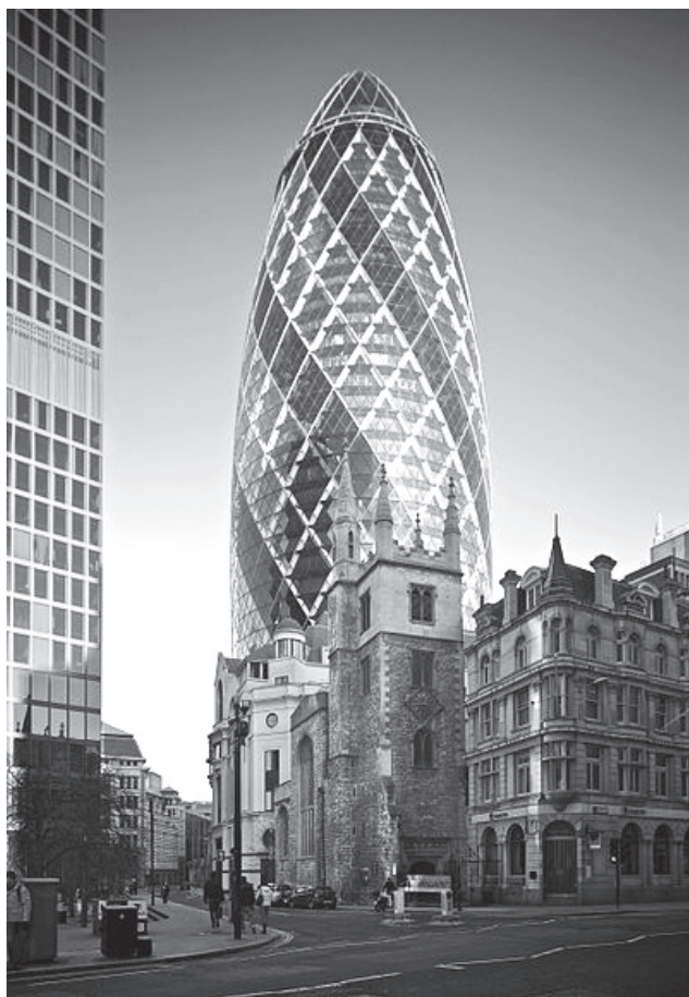
شکل ۶- ساده سازی و تکرارپذیری در طرح پوشش شیشه ای ساختمان «سوییس آرایبی» - استفاده از شیوه تکرار دورانی
