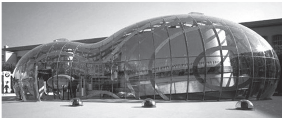
شکل ۸- نمای بیرونی پروژه حباب - متشکل از ۳۵۰ قطعه متفاوت از جنس شیشه اکریلیک
