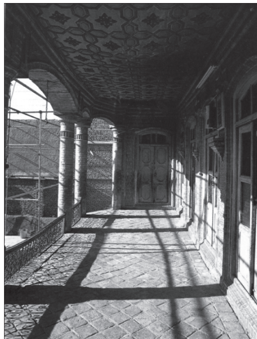
تصویر ۲-۲۱: سایبان عریض یا بالکن در اقلیم گرم برای پنجره رو به جنوب یا جنوب شرقی
