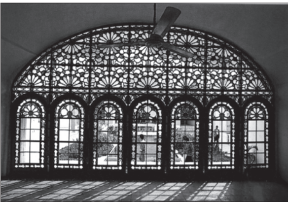
تصویر ۲-۷: استفاده از سطوح خازن برای کنترل گرمای جذب شده
