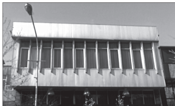
تصویر ۲-۲۲: نحوه‌ی طراحی و خصوصیات سایبان پنجره‌ی فرضی رو به شمال و یا جهت‌های نزدیک به آن
