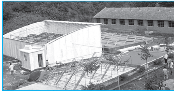
مخزن بیوگاز با گنجایش ۲۰۰ مترمکعب برای تصفیه فضولات ۱۰۰۰ راس دام. مقدار بیوگاز تولید شده قادر به تامین انرژی روزانه ۱۰۰ خانوار روستایی است. استان میون چین [۲۱]
