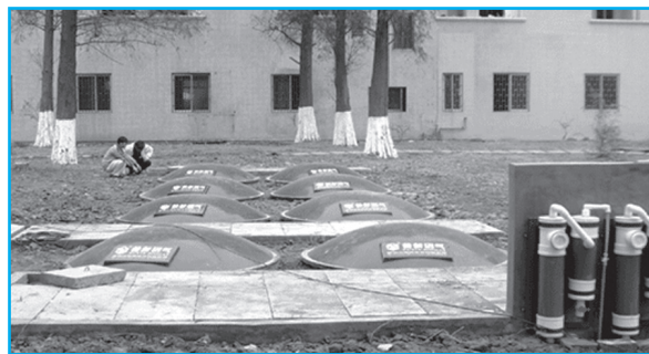
مخزن بیوگاز با گنجایش ۱۰۰ مترمکعب برای تصفیه فاضلاب ۵۰۰ نفر. گاز حاصله در یک رستوران به‌عنوان سوخت مورد استفاده قرار می‌گیرد. شهر دانگوان چین [۲۱]
