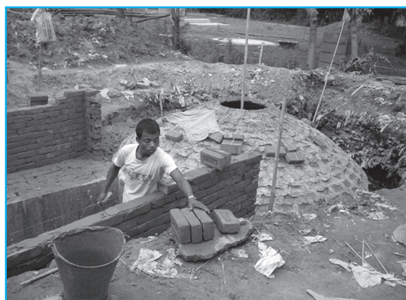
ساخت واحد بیوگاز مخزن ثابت با استفاده از مصالح بنایی
