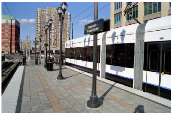
ایستگاه LRT روزمینی
