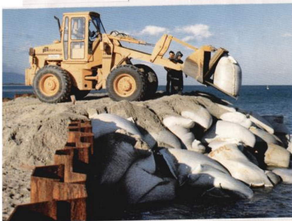
شکل ۶-۱۴- اجرای استفاده از کیسه های ژئوتکستایل پر شده از ماسه بر روی خاکریزهای ایجاد شده
