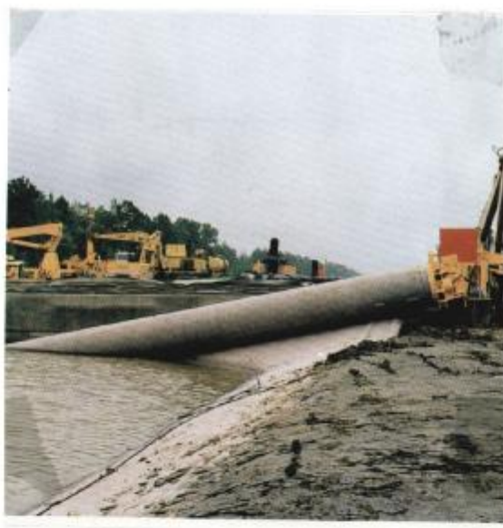
شکل ۵-۷- نحوه گستردن ژئوتکستایل در سواحل رودخانه ها
