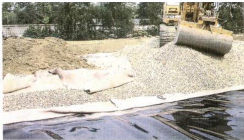
شکل ۵-۹- نحوه اجرایی استفاده از ژئوتکستایل به منظور حفاظت از ژئوممبرین در مقابل فرسایش و پنچری
