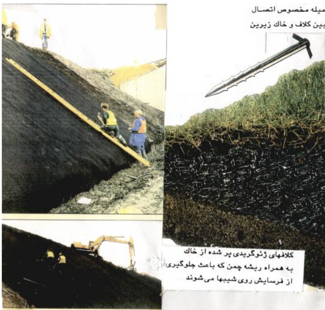
شکل ۵-۳- اجرای کلاف ژئوگرید جهت مسلح نمودن چمن در شیبهای ۴۵ درجه و کمتر
