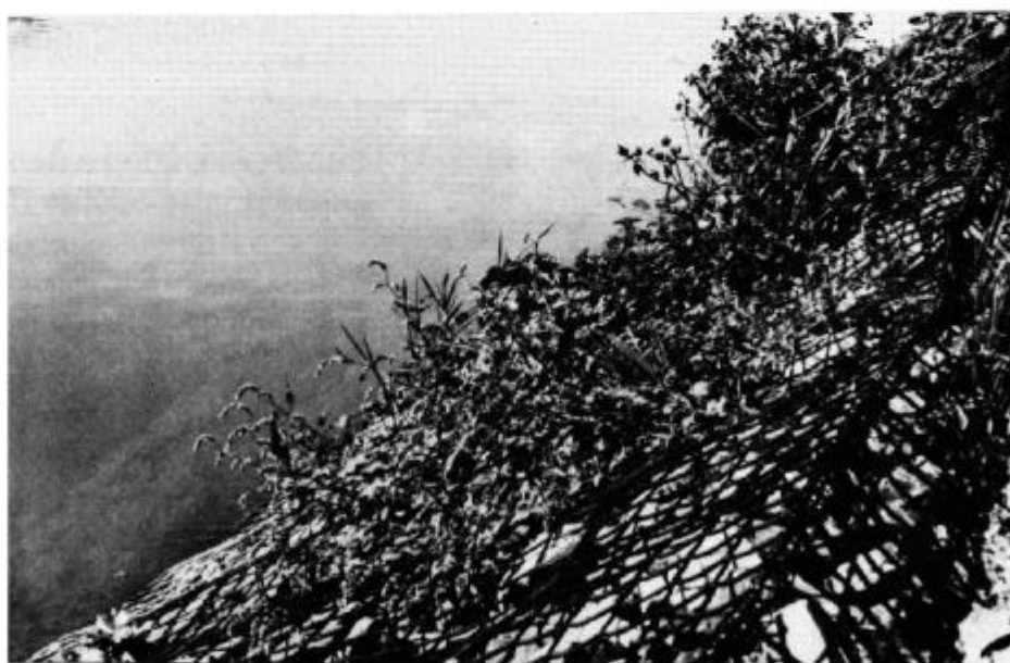
شکل ۱۱-۵- تصویر اجرا شده پوشش ژئوگریدی پر شده از سنگ
