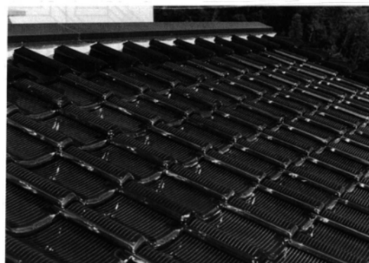
شکل ۱۴: استفاده از آمورتون در سقفهای شیبدار و سفالی بام
