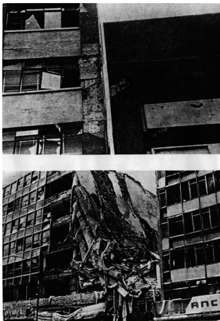
شکل ۱۸ - خسارت و تخریب ساختمانها در اثر کوبش درزهای زلزله در زمین لرزه سپتامبر سال ۱۹۸۵ در مکزیکوسیتی.
