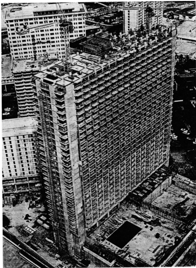
شکل ۹ (ت). هتل ALA MOANA در هاوایی. در هر ۴ طرف ساختمان از قطعات بتونی پیش ساخته بعنوان دیوار استفاده گردید که رانش بین طبقات به حداقل برسد.
