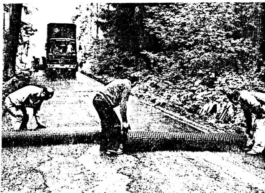
نصب Rehau Armapal تقویت کننده ای که جاذب مناسب تنش ها و کاهش دهنده ترکها است.
